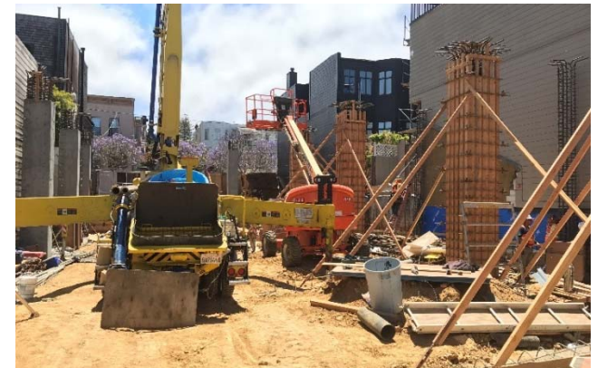
FS 16 Columns Concrete Pour
